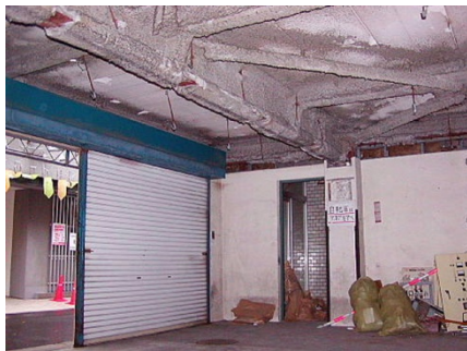
吹付け石綿等が飛散し暴露する可能性が高い
