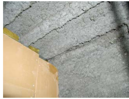
吹付け石綿等が飛散し暴露する可能性が高い
